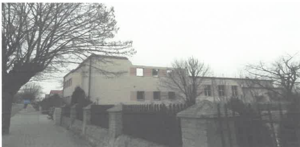
Zdjęcie nr 2 - widok na budynek przed remontem
