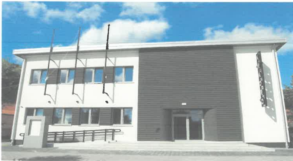
Zdjęcie nr 4 – budynek po modernizacji, widok od strony ulicy Nowowiejskiego
