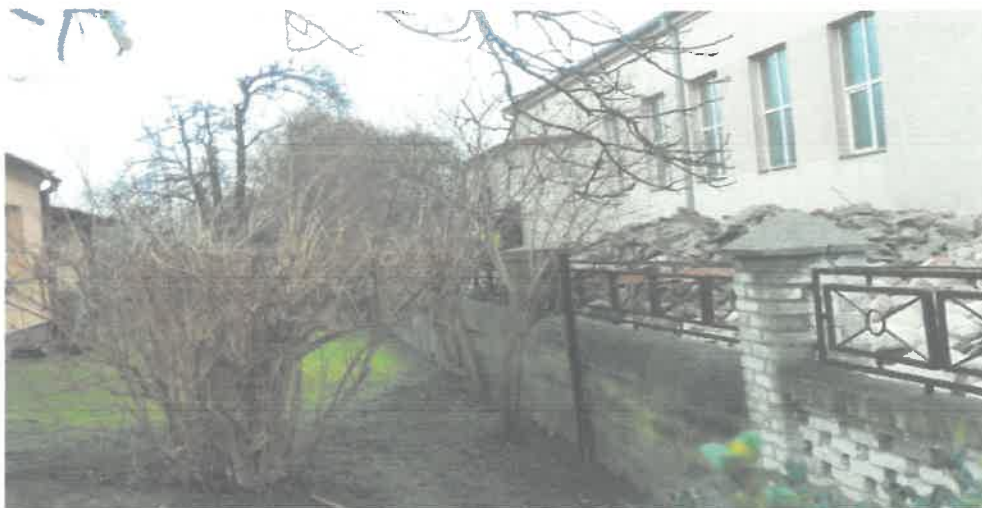
Zdjęcie nr 1- stan budynku i ogrodzenia przed modernizacją
