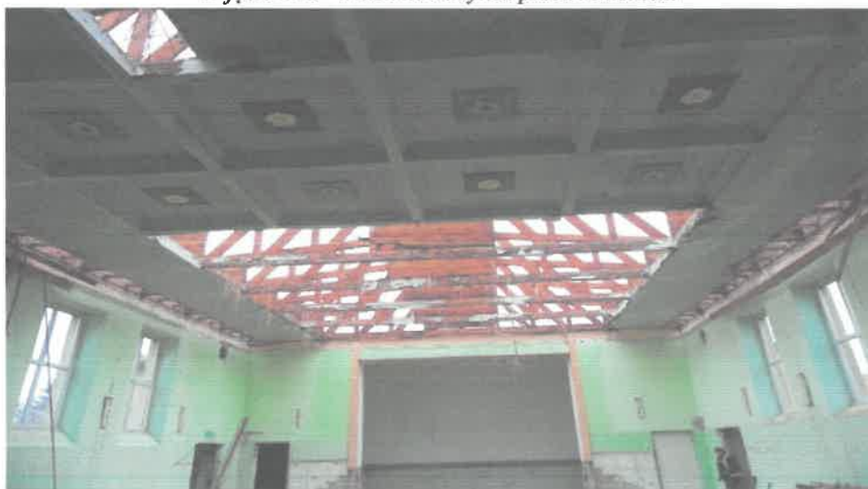
Zdjęcie nr 3 - wnętrze budynku w trakcie remontu
