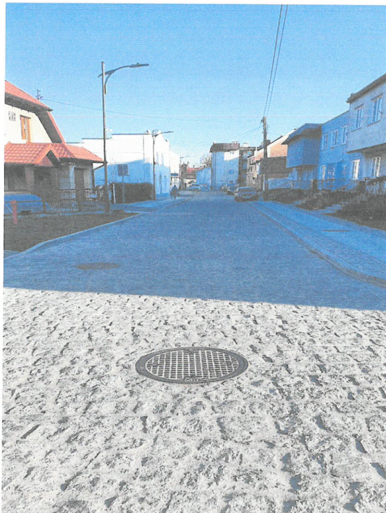
Zdjęcie nr 1- przebudowana ulica Młyńska w Sztumie
