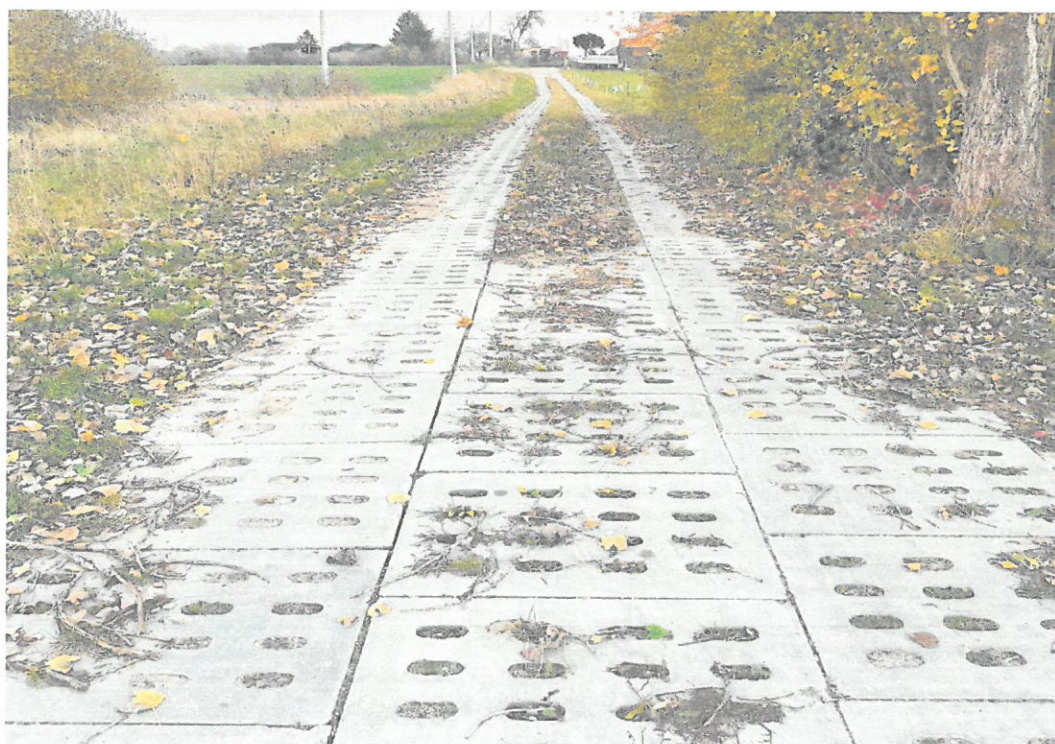
Odcinek drogi w Postolinie
