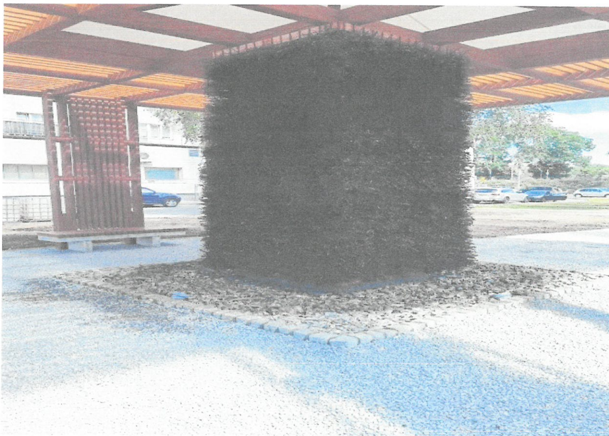
Zdjęcie nr 3- przedstawia zbliżenie wnętrza tężni- zbliżenie na słup tężni wykonany z tarniny
