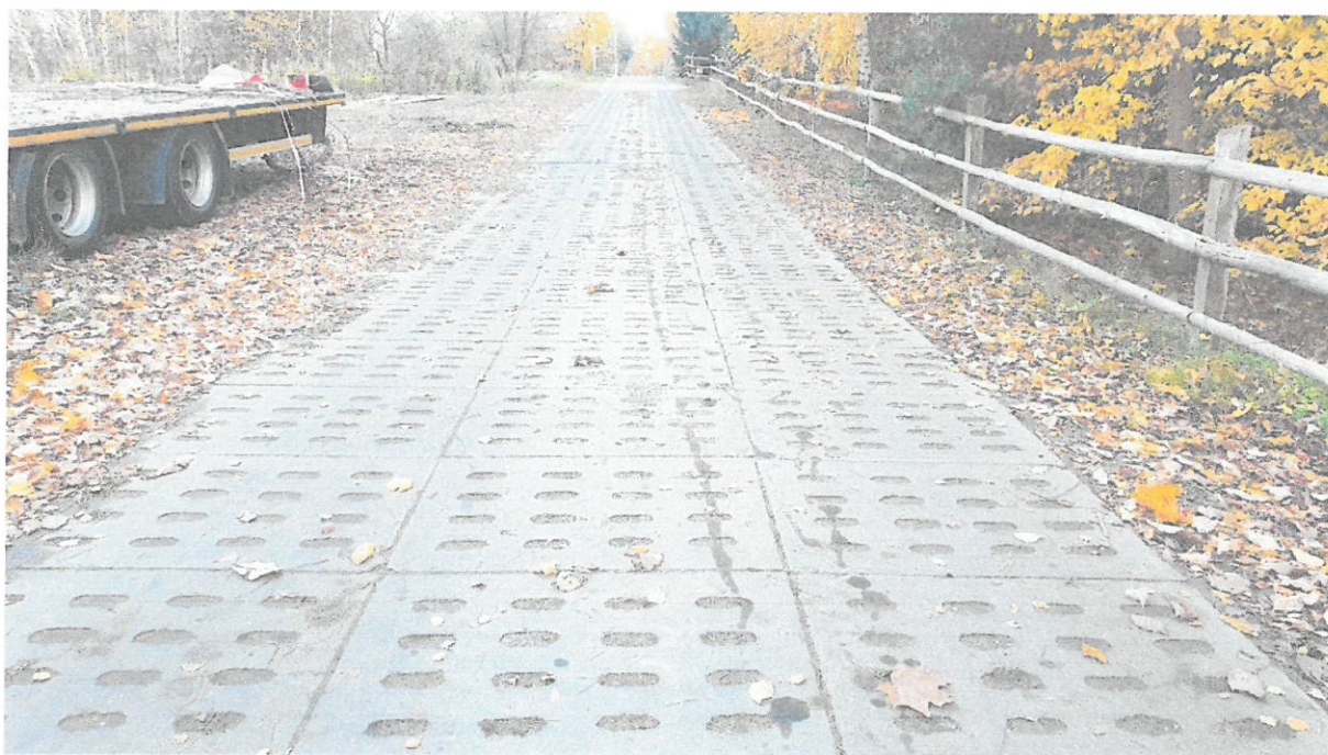
Odcinek drogi w Gościszewie
