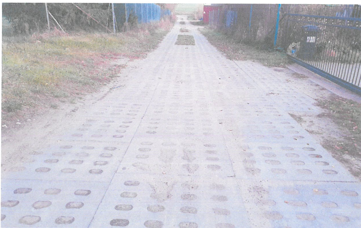
Odcinek drogi w Gościszewie
