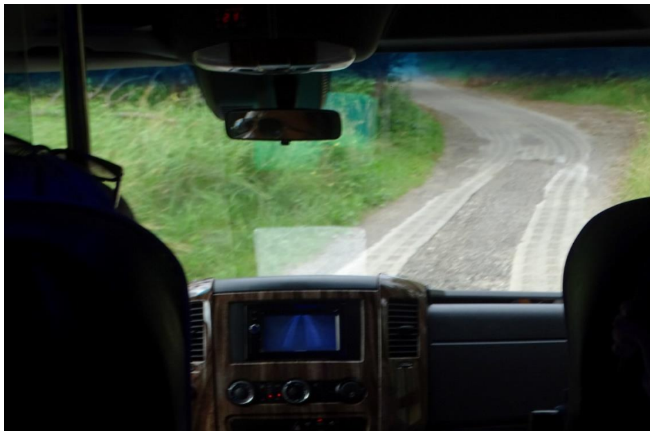
Zdjęcie nr 7- przejazd drogą gminną wykonaną z płyt jumbo
