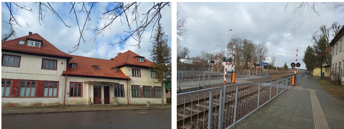
Fot. 17. Dworzec kolejowy leżący na obszarze rewitalizacji
