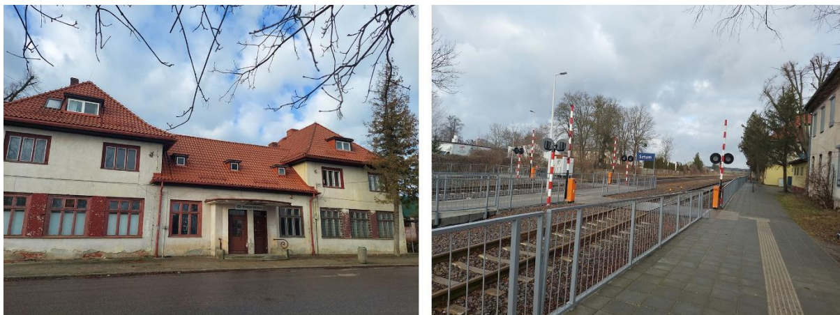
Fot. 17. Dworzec kolejowy leżący na obszarze rewitalizacji
